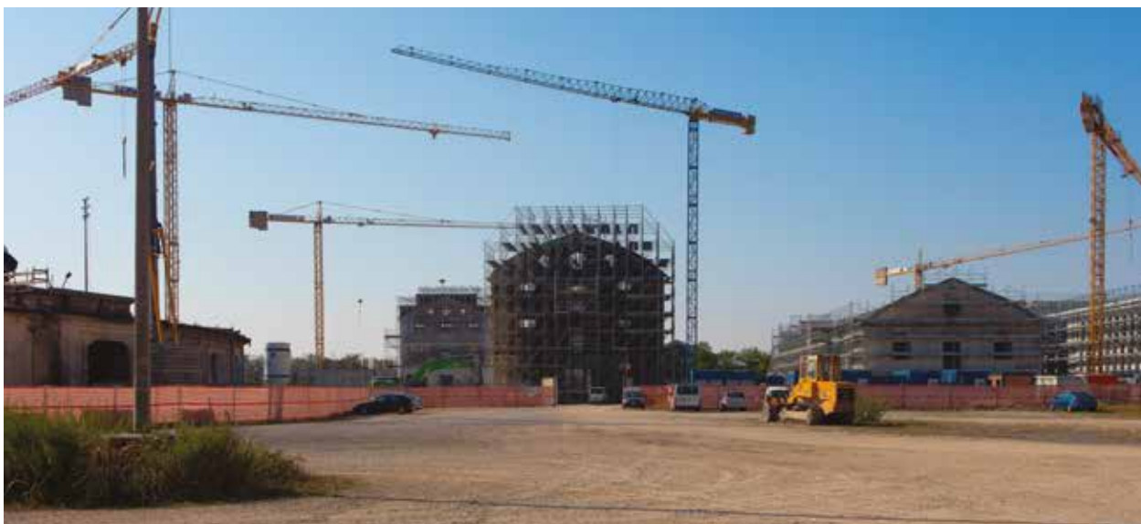
Verona, Area Ex-Magazzini Generali. Avanzamento dei lavori a febbraio 2016.
