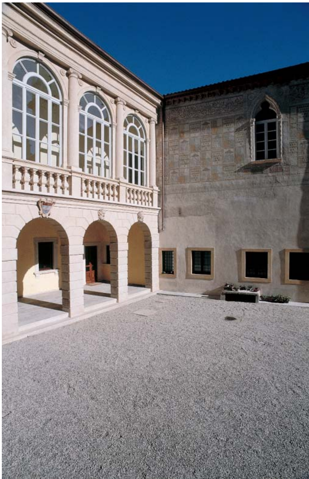
VERONA, Vescovado - restauro delle facciate degli'edifici sud (XVI sec.) ed est (XVII sec.)
